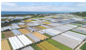
芸西村ハウス群・ほ場整備工事
