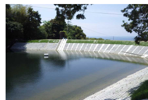
ため池改修工事
