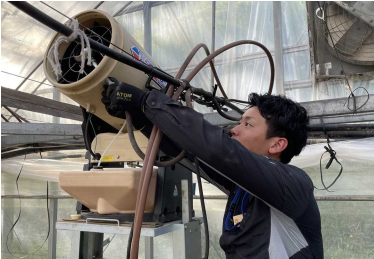
常温煙霧機の設置作業の様子
