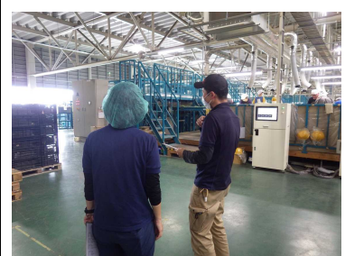
出荷場内を点検
