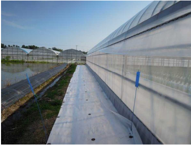
防虫ネットとハウス周りにシートを設置した試験ハウスの様子
