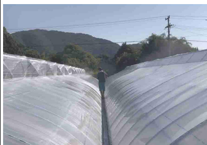
遮熱塗布資材散布の様子
