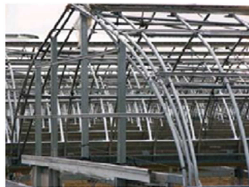
画像2 アーチパイプの増設事例
