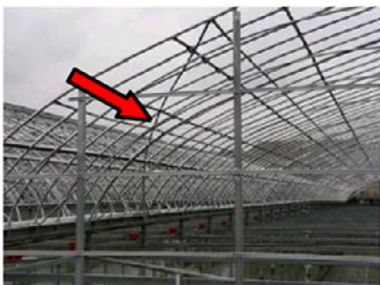
画像3 筋交いパイプによる補強事例
