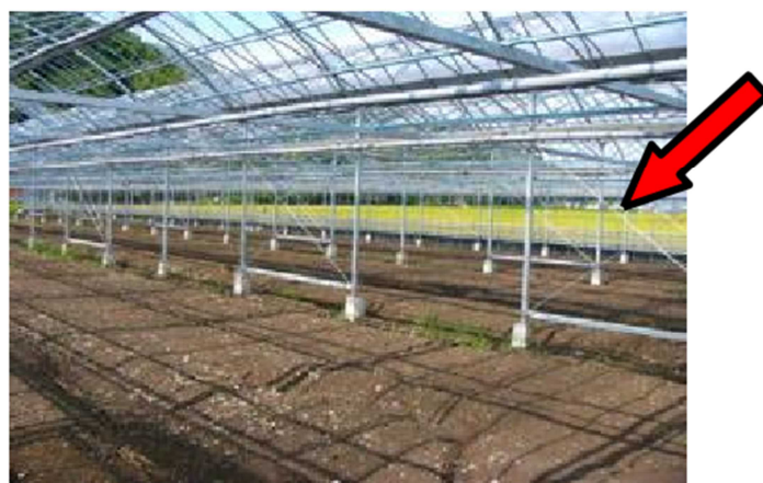
画像5 谷柱の筋交い補強事例
