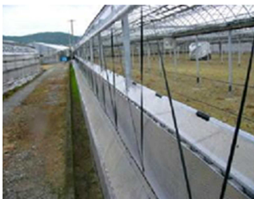
画像1 ハウスバンド、ハウスバンドフック の点検は重要
