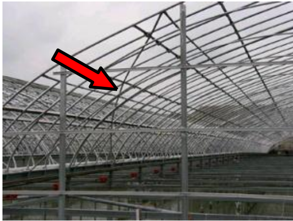
画像3 筋交いパイプによる補強事例
