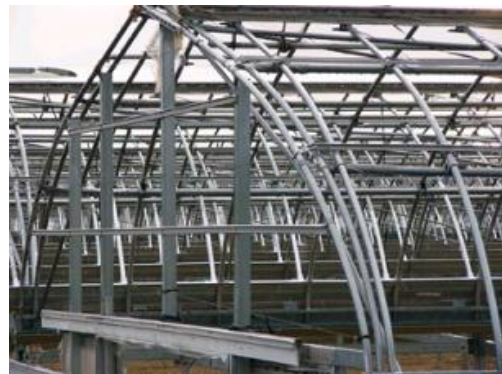
画像2 アーチパイプの増設事例
