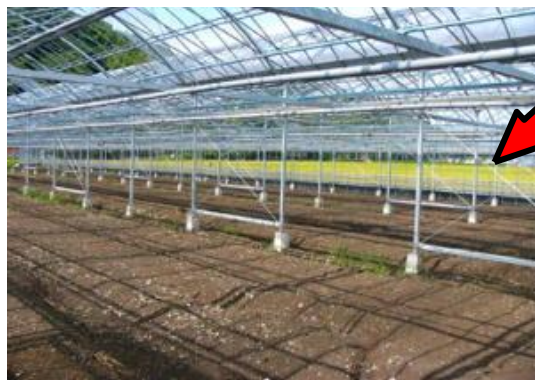
画像5 谷柱の筋交い補強事例
