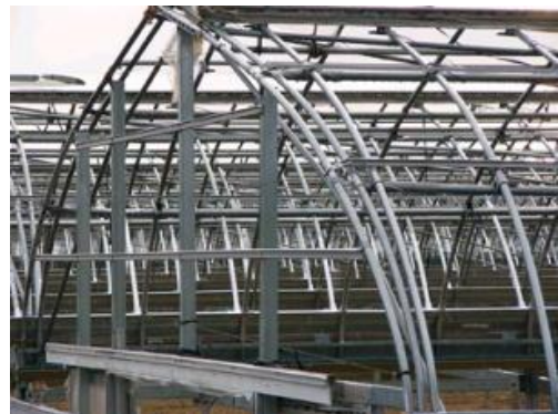
画像2 アーチパイプの増設事例
