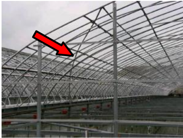
画像3 筋交いパイプによる補強事例
