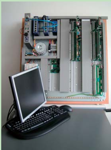
写真2 Priva 本社のハウス環境制御 コンピュータ (研修用)
