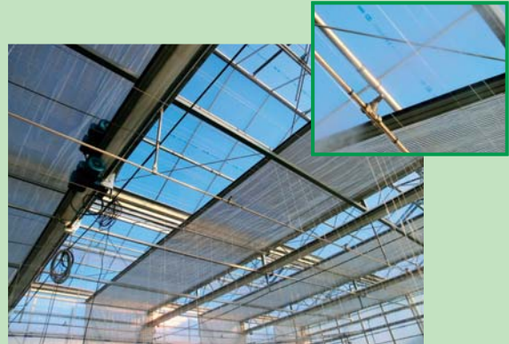
遮光スクリーンと細霧装置による 温湿度制御
