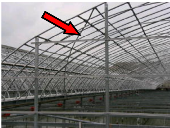
画像3 筋交いパイプによる補強事例
