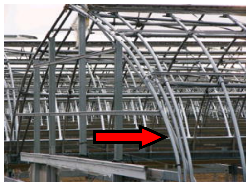
画像2 アーチパイプの増設事例
