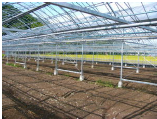
画像5 谷柱の筋交い補強事例
