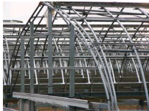
画像2 アーチパイプの増設事例
