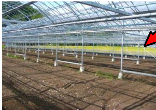
画像5 谷柱の筋交い補強事例
