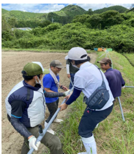
土壌還元消毒の配管作業の様子
